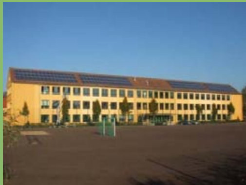
Bürgersolaranlage auf der Integrierte Gesamtschule
