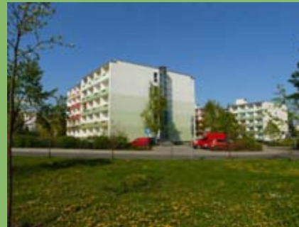
Fernwärmebeheizte Kleinwohnungen in Kiefernheide
